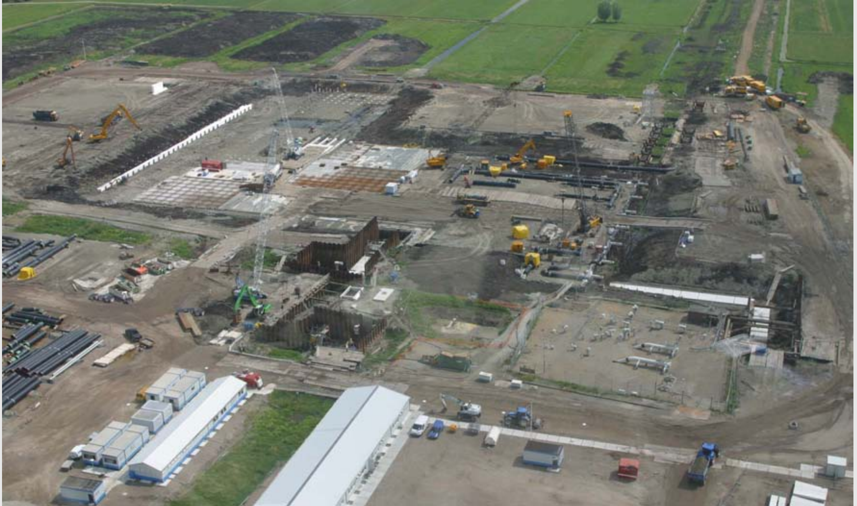
Nieuwbouw compressorstation Gasunie, Wijngaarden
