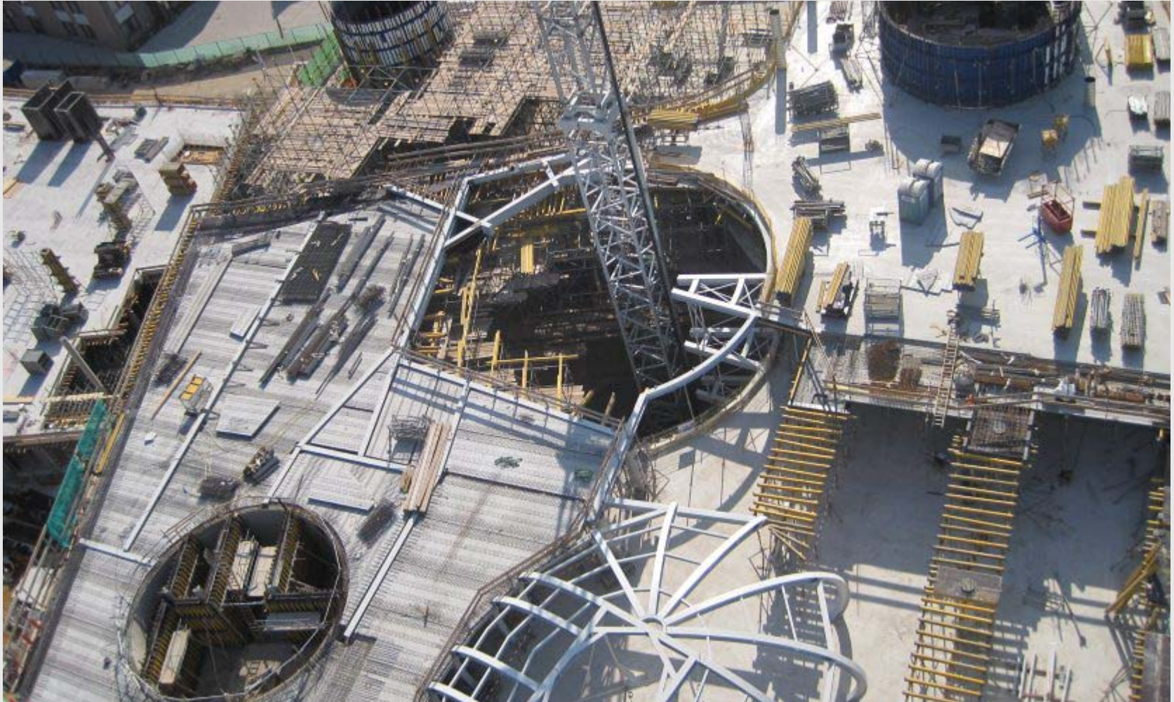
Nieuwbouw stadhuis Nieuwegein
