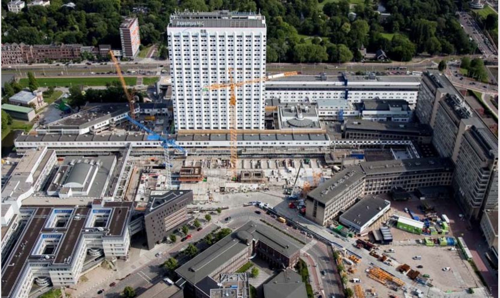
Nieuwbouw ziekenhuis Erasmus MC, Rotterdam
